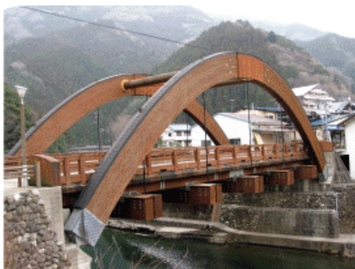
木造集成材の橋
